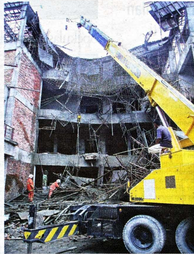
AHLI bomba cuba mengeluarkan mangsa di tapak projek pembinaan bangunan Institut Oseanografi dan Institut Akuakultur UMT, semalam.
